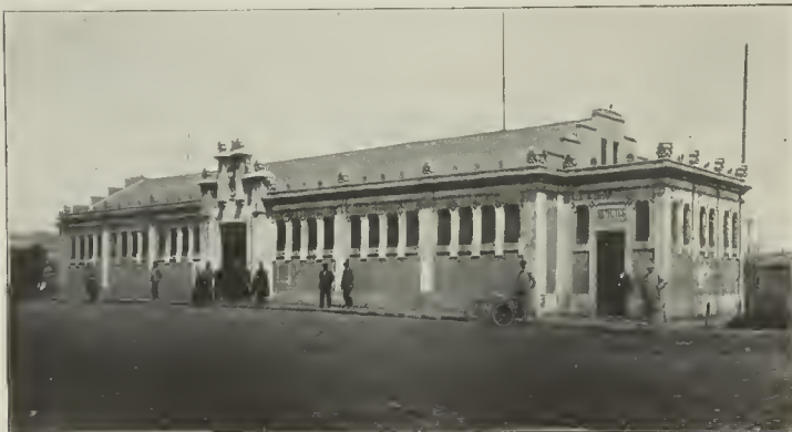
Edificio de la Dirección de Sanidad del puerto
